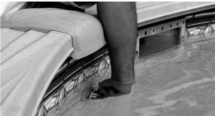
5. Asegúrese de que la bomba de filtración esté APAGADA (OFF) para que no fluya agua fuera del filtro cuando se desconecte la manguera de retorno de la entrada de retorno de la piscina.
